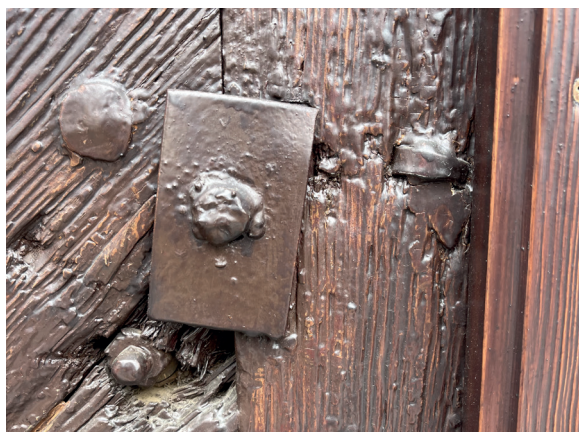
Fot. 18 Elewacja południowa, detal drzwi frontowych, znaczne zniszczenia powierzchni, ubytki oraz klamrowanie konstrukcji.
