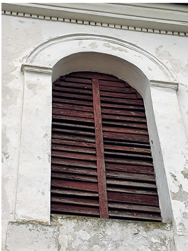
Fot. 37 Dzwonnica, żaluzja w elewacji południowej, widoczne zniszczenia elementów drewnianych i zniekształcone detale sztukatorskie.
