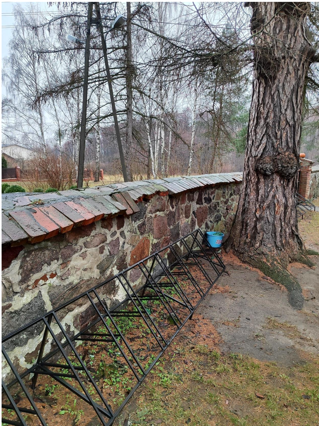
Fragment I-J – zniszczona nakrywa ceglana, szczelne spoiny cementowe.
