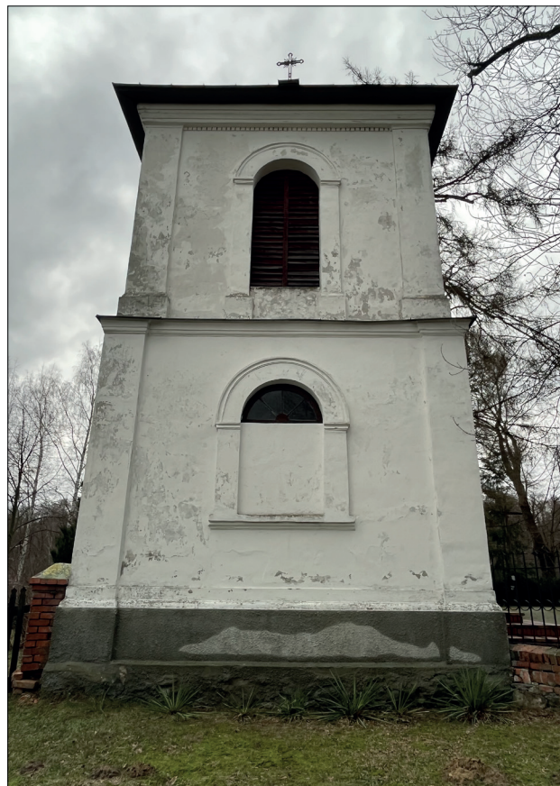
Fot. 32 Dzwonnica, elewacja południowa, widoczne zniszczenia w partii tynku narażonej na działanie wody.
