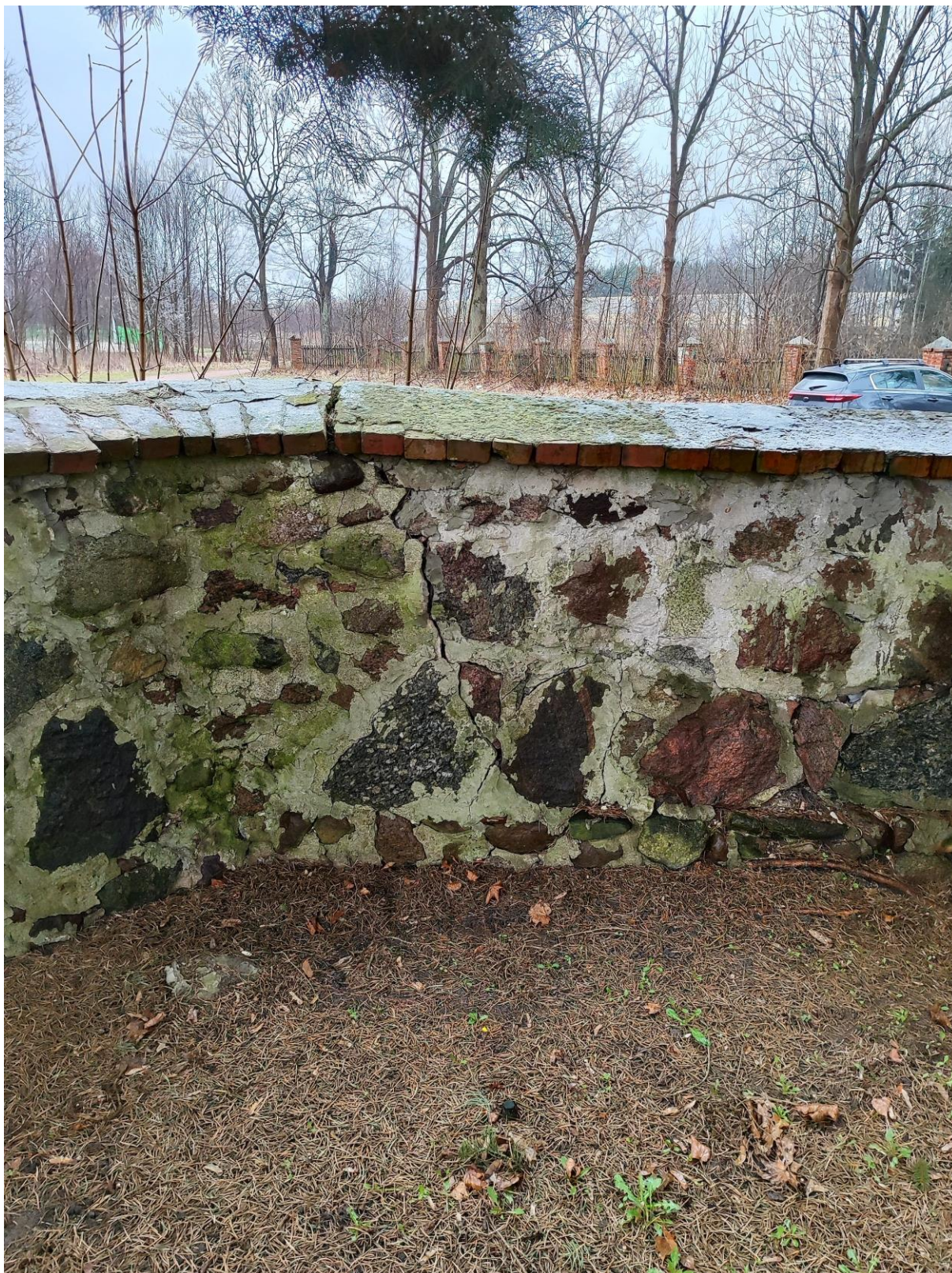
Narożnik E – pęknięty konstrukcyjnie narożnik, szczelne, cementowe spoiny, zniszczona nakrywa ceglana.
