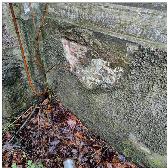
Fot. 41 Widoczne zniszczenia obrzutki cementowej w partii cokołu.
