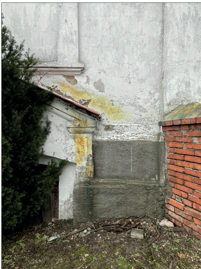
Fot. 40 Dzwonnica, elewacja zachodnia, powyżej szczelnego cementowego cokołu widoczne znaczne zniszczenia w onszarze tynku spowodowane podciąganiem kapilarnym wody i wysoleniami, przez niezabezpieczony otwór drzwiowy w przyziemiu zalewana jest kondygnacja piwniczna.
