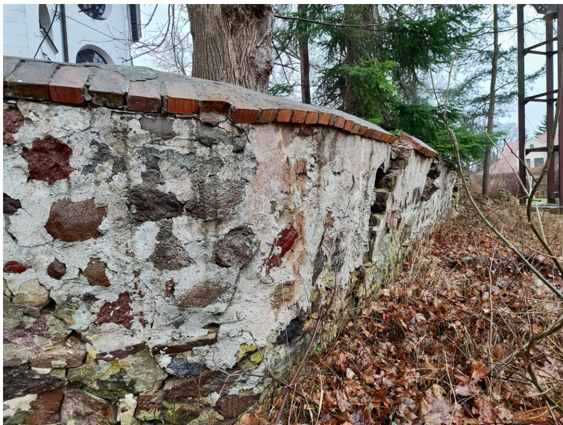
Narożnik G – wychylenie od pionu zagrażające katastrofą, obszerne ubytki i spękania.
