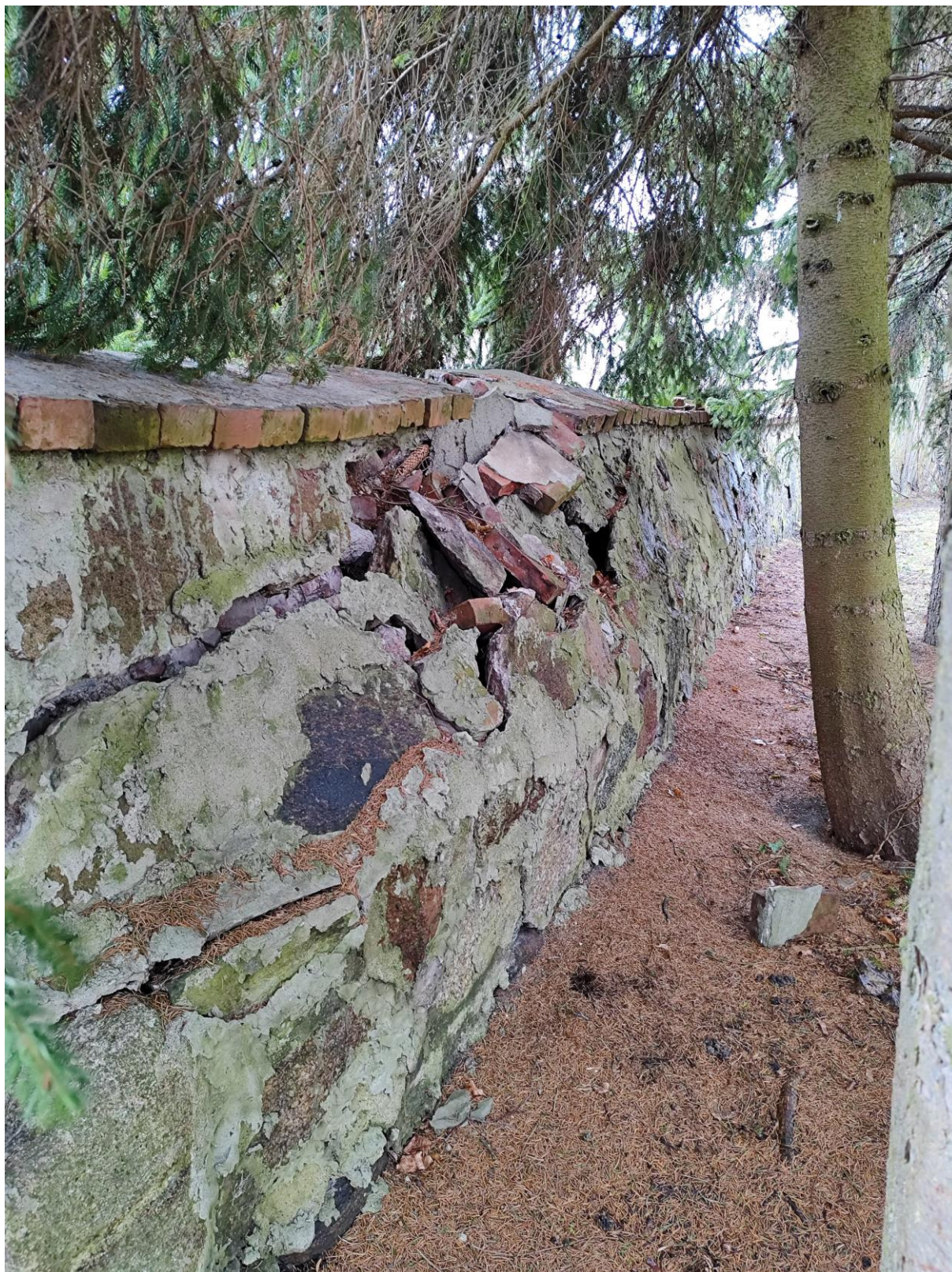
Fragment E-D – zniszczenia konstrukcyjne ogrodzenia, wypchnięcie muru na zewnątrz.
