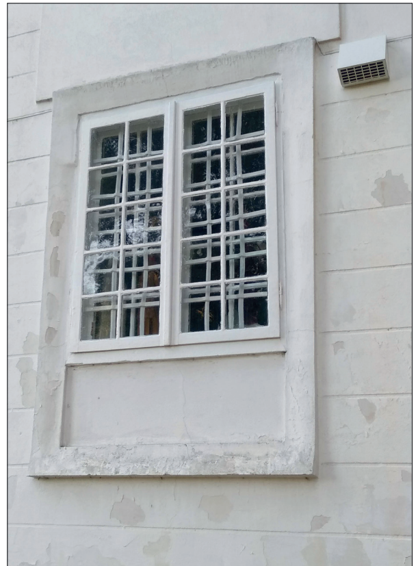
Fot. 9 Elewacja wschodnia; Wtórne zewnętrzne okno, wewnątrz zachowana pierwotna kratka okienna; widoczny zniekształcony detal w partii opaski okiennej.
