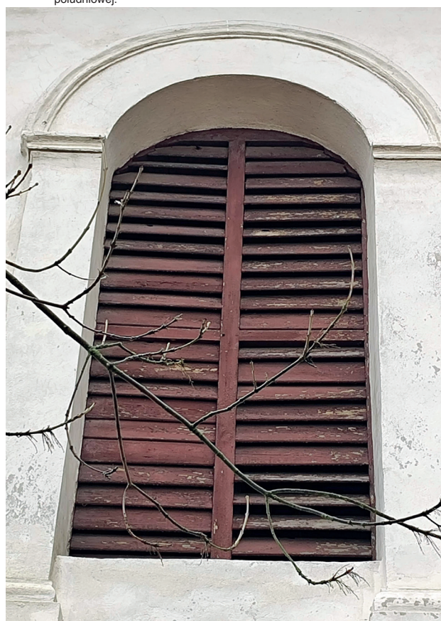
Fot. 38 Dzwonnica, żaluzja w elewacji wschodniej, widoczne zniszczenia elementów drewnianych i zniekształcone detale sztukatorskie.
