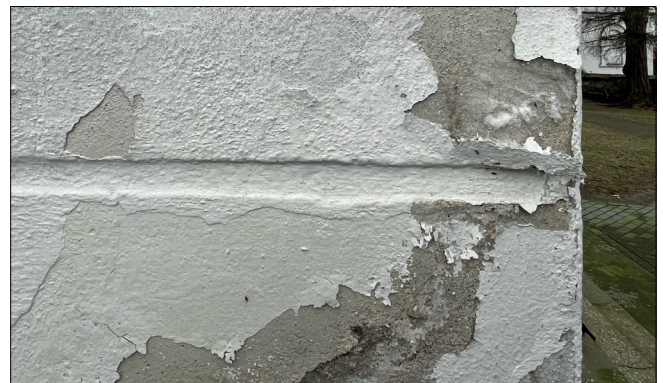
Fot. 6 Elewacja północna; widoczne znaczne sole krystalizujące na powierzchni tynku.
