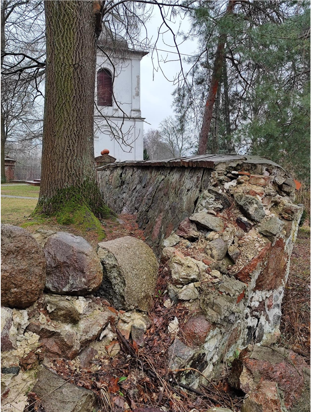
Fragment H-I od słupka ceglanego przy furtce do narożnika H ogrodzenie wychylone od pionu, zagrażające katastrofą.
