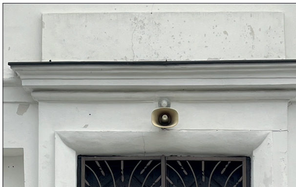
Fot. 5 Elewacja południowa; widoczne spękanie w nadprożu drzwi frontowych.
