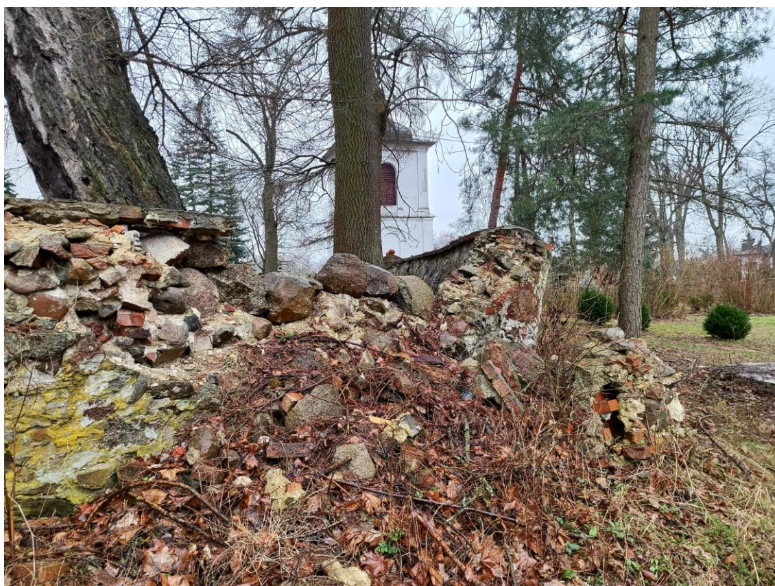
Narożnik H – ogrodzenie zawaliło się. Pozostała część w stanie zagrażającym katastrofą.
