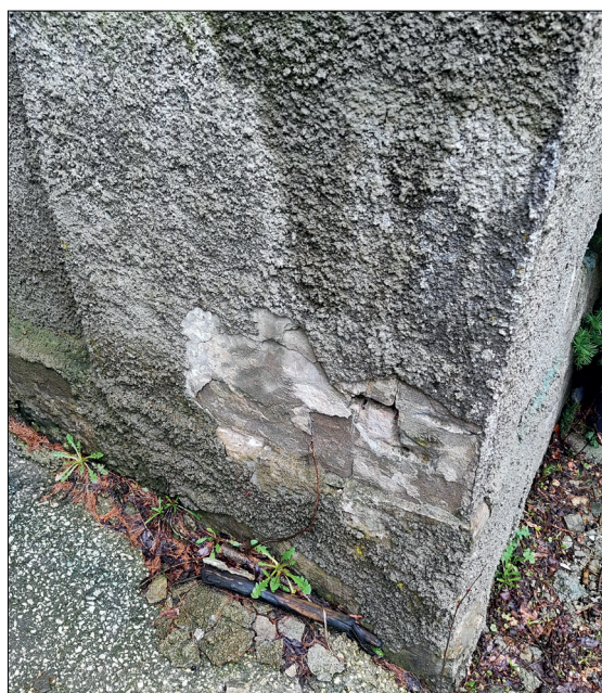
Fot. 42 Widoczne zniszczenia obrzutki cementowej w partii cokołu.
