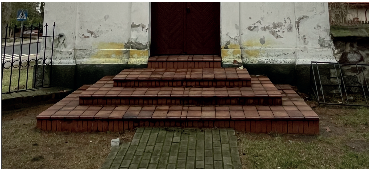
Fot. 39 Dzwonnica, wtórne schody przy wejściu w elewacji wschodniej; powyżej szczelnego cementowego cokołu widoczne znaczne zniszczenia w onszarze tynku spowodowane podciąganiem kapilarnym wody i wysoleniami.
