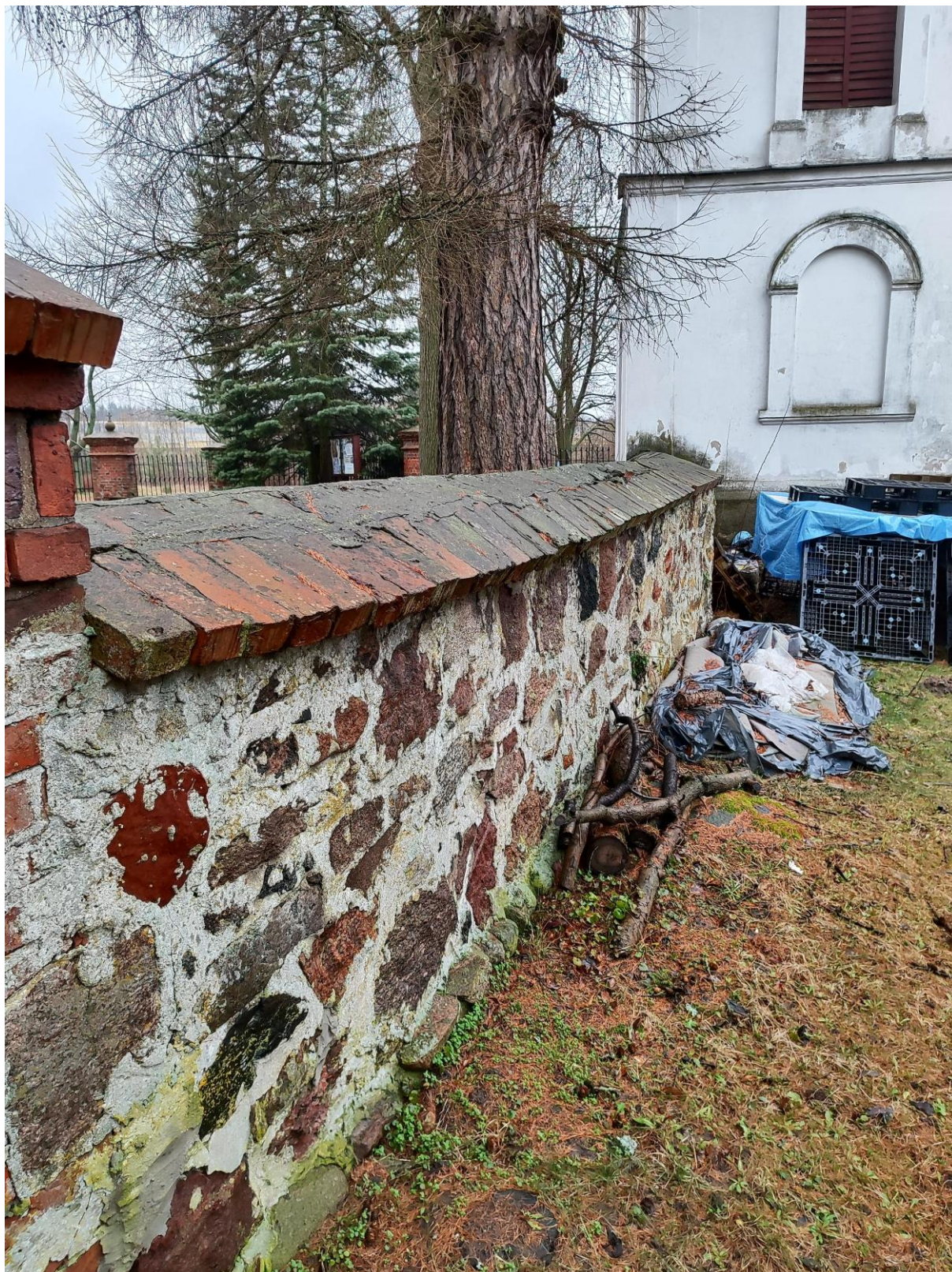
Fragment H-J – zniszczona nakrywa, szczelne spoiny.
