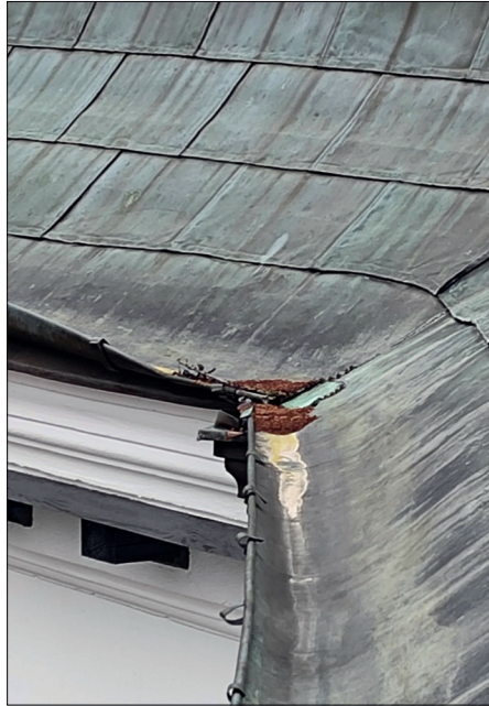
Fot. 20 Obróbki blacharskie, widoczne odkształcone rynny leżące.
