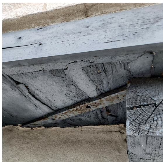
Fot. 29 Widoczne konstrukcyjne wzmocnienie narożnika gzymsu płaskownikiem stalowym.
