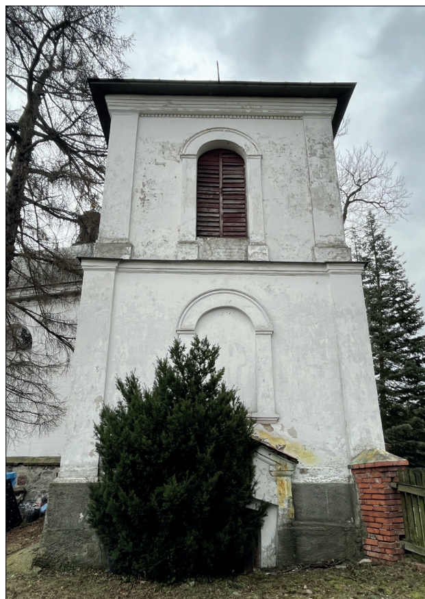
Fot. 34 Dzwonnica, elewacja zachodnia, widoczne uszkodzenia warstwy malarskiej oraz zniszczenia w partii cokołowej na skutek działania wody.
