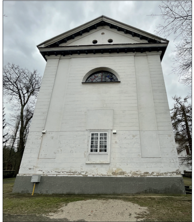
Fot. 2 Elewacja północna; w partii przyziemia widoczna znaczna degradacja tynków i powłok malarskich na skutek podciągania kapilarnego, wysoleń i przemarzania, w dolnej części cokołu widoczne zawilgocenia i obszary porażenia mikrobiologicznego.
