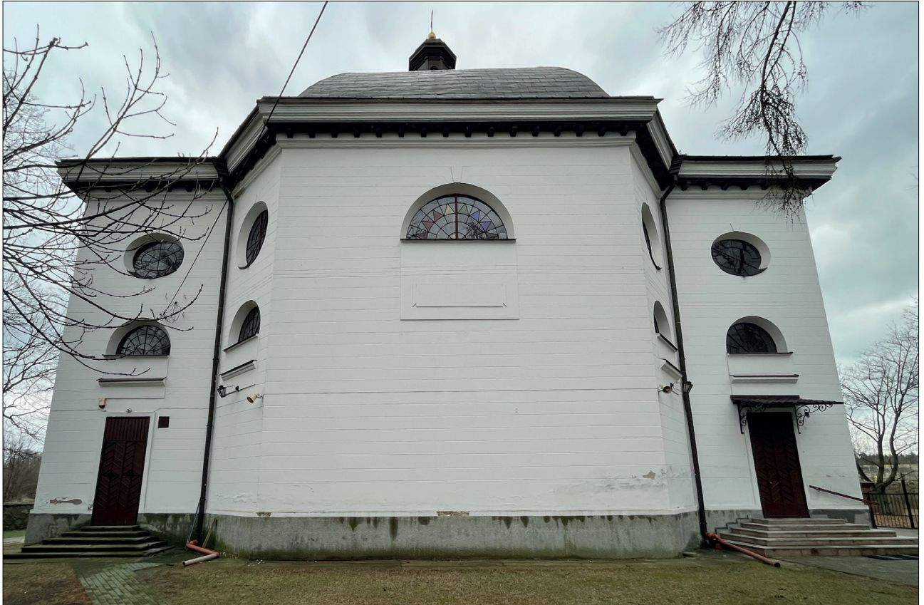
Fot. 10 Elewacja zachodnia; w partii przyziemia powyżej cokołu widoczna znaczna degradacja tynków i powłok malarskich na skutek podciągania kapilarnego, wysoleń i przemarzania, w dolnej części cokołu widoczne zawilgocenia i obszary porażenia mikrobiologicznego. Do rur spustowych dołączono nieestetyczne przedłużki z PCV w celu odprowadzenia wody dalej od elewacji.
