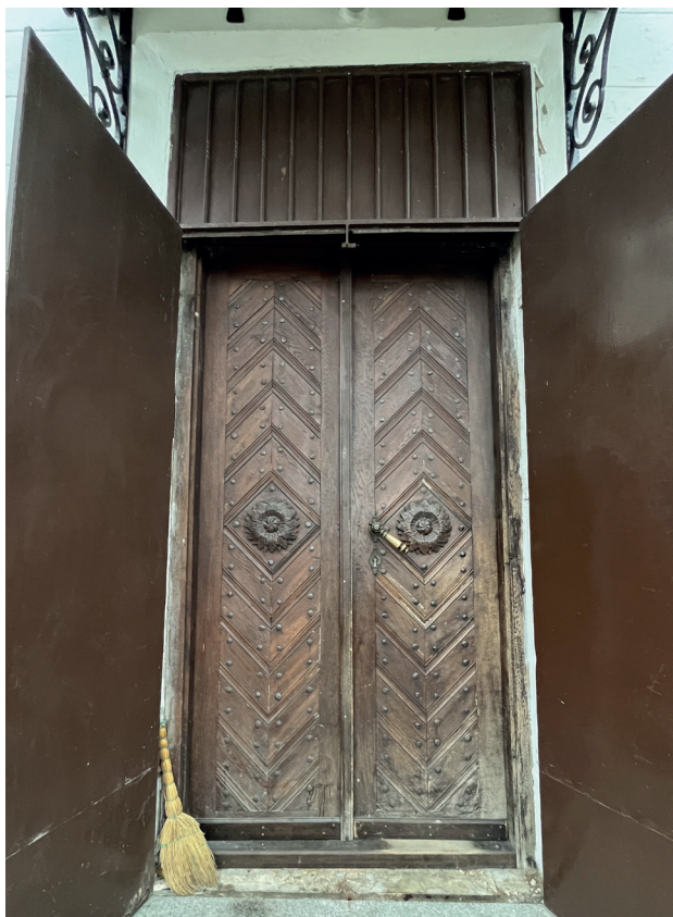
Fot. 14 Elewacja zachodnia; historyczne drzwi w części południowej zachowane w dobrym stanie technicznym.
