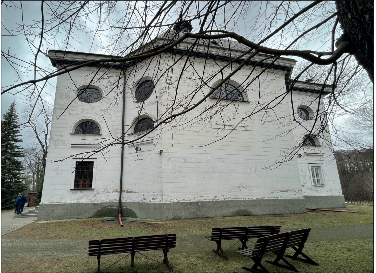
Fot. 7 Elewacja wschodnia; w górnej partii ścian widoczna degradacja powłok malarskich na skutek erozji, w partii przyziemia widoczna znaczna degradacja tynków i powłok malarskich na skutek podciągania kapilarnego, wysoleń i przemarzania, w dolnej części cokołu widoczne zawilgocenia i obszary porażenia mikrobiologicznego. Do rur spustowych dołączono nieestetyczne przedłużki z PCV w celu odprowadzenia wody dalej od elewacji.
