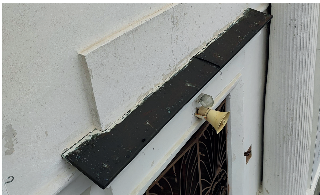
Fot. 29 Widoczne konstrukcyjne wzmocnienie narożnika gzymsu płaskownikiem stalowym.
