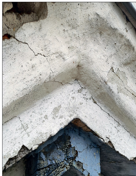
Fot. 27 Elewacja północna, widoczne spękania gzymsu w szczycie tympanonu.
