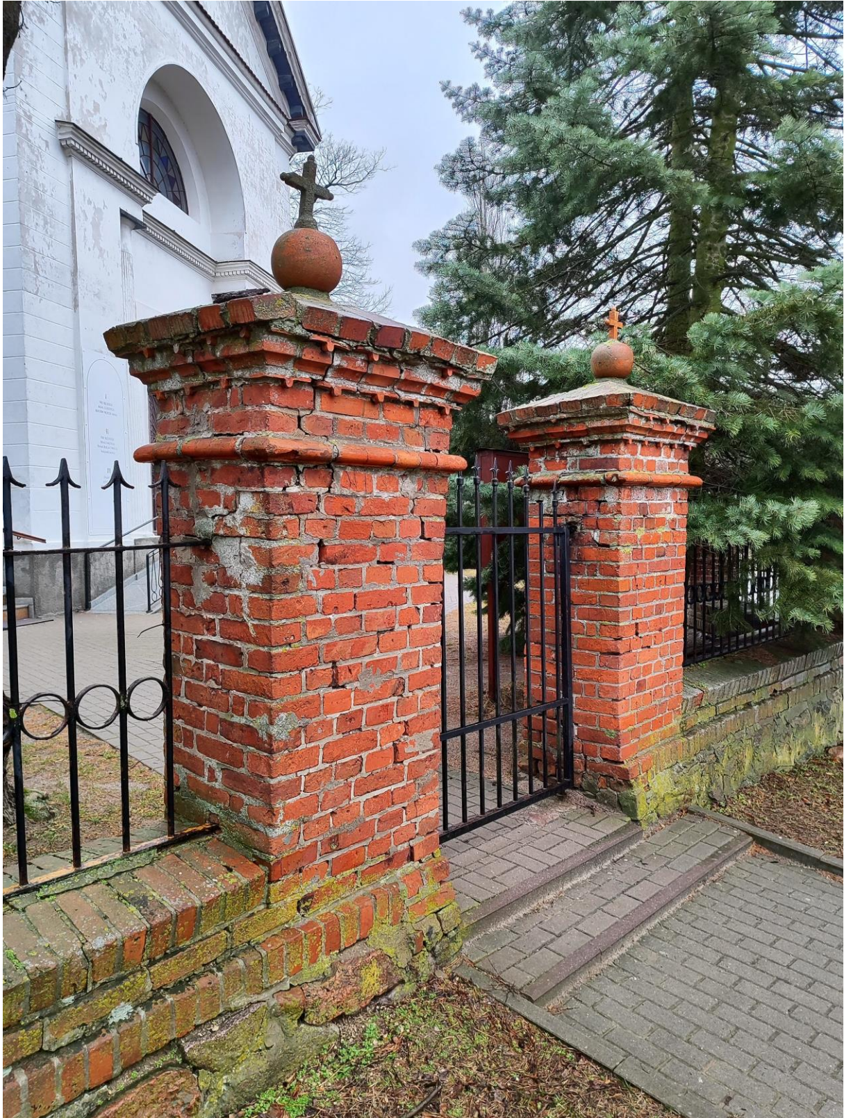
Fragment A-B – spękania konstrukcyjne słupka ceglanego, uszkodzenia nakrywy, ubytki cegły i spoin, furta i przesła do renowacji
