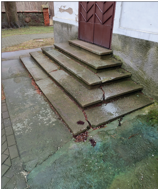
Fot. 11 Elewacja zachodnia; ze względu na zły stan techniczny schody w części północnej wymagają wymiany.
