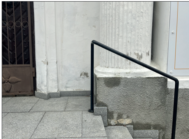
Fot. 3 Elewacja południowa (frontowa); w dolnej partii ścian widoczna degradacja tynków i powłok malarskich na skutek szkodliwego działania wody podciąganej kapilarnie.
