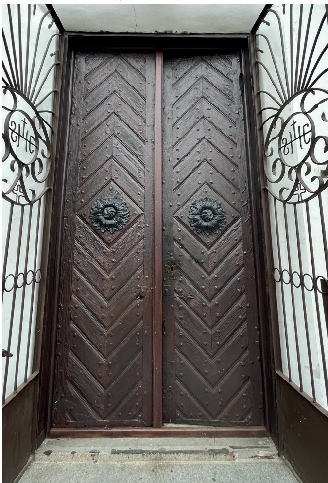
Fot. 16 Elewacja południowa; zachowane drzwi historyczne, widoczna wtórna listwa przymykowa.
