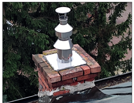
Fot. 25 Komin w części północnej, widoczne ubytki w wymurowaniu.
