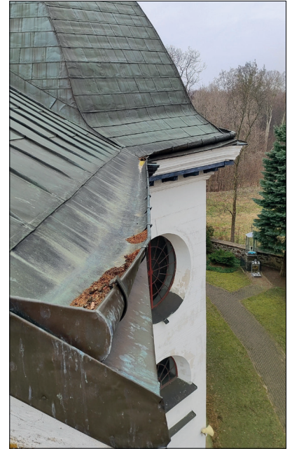
Fot. 21 Obróbki blacharskie, widoczne odkształcone rynny leżące.
