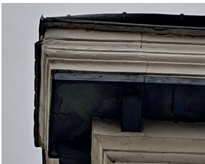
Fot. 28 Elewacja północna, widoczne konstrukcyjne spękania gzymsu, wydzielenie się narożnika.
