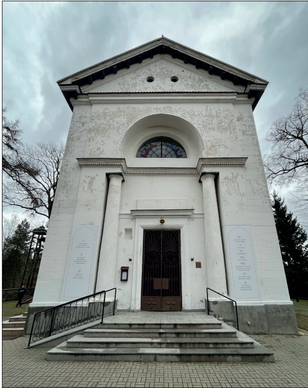
Fot. 1 Elewacja południowa; w górnej partii ścian widoczna degradacja warstw malarskich, w partii cokołowej widoczne zawilgocenia i obszary porażenia mikrobiologicznego. W partii detalu sztukatorskiego widoczne uproszczone i nieestetyczne rekonstrukcje w zakresie opaski drzwiowej oraz detalu kolumn.
