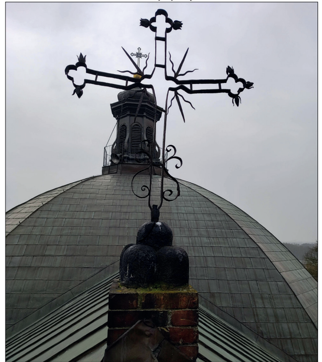
Fot. 23 Krzyż w części północnej, widoczna odkształcona konstrukcja, zanieczyszczona podstawa
