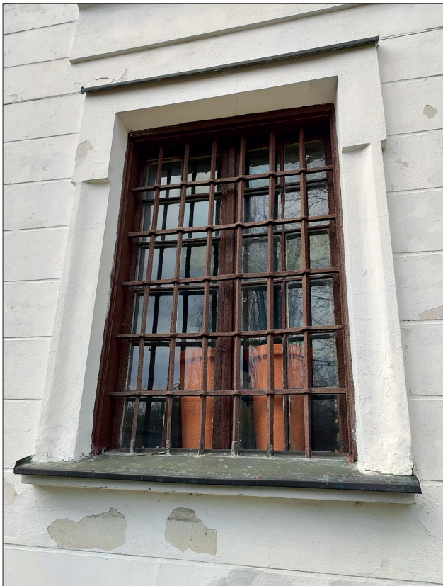
Fot. 8 Elewacja wschodnia; zachowana pierwotna kratka okienna; widoczny zniekształcony detal w partii opaski okiennej; stolarka okienna zachowana w dobrym stanie konstrukcyjnym, widoczne powierzchniowe zniszczenia, brakuje okna zewnętrznego.
