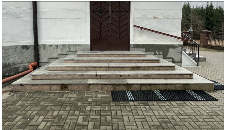
Fot. 10 Elewacja zachodnia; w partii przyziemia powyżej cokołu widoczna znaczna degradacja tynków i powłok malarskich na skutek podciągania kapilarnego, wysoleń i przemarzania, w dolnej części cokołu widoczne zawilgocenia i obszary porażenia mikrobiologicznego. Do rur spustowych dołączono nieestetyczne przedłużki z PCV w celu odprowadzenia wody dalej od elewacji.
