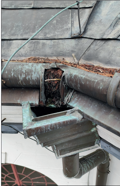
Fot. 19 Obróbki blacharskie, widoczne niedrożne rynny leżące przy krawędzi dachu.
