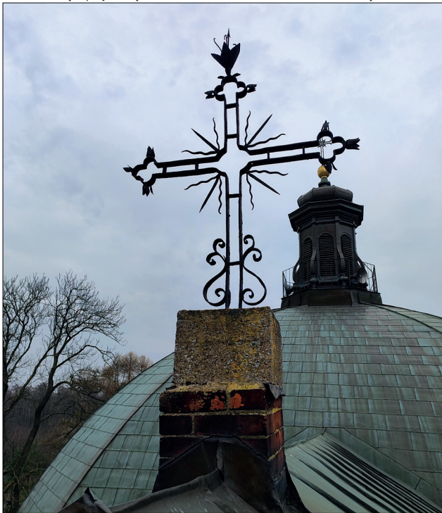
Fot. 22 Krzyż w części południowej, widoczna przebudowana podstawa.
