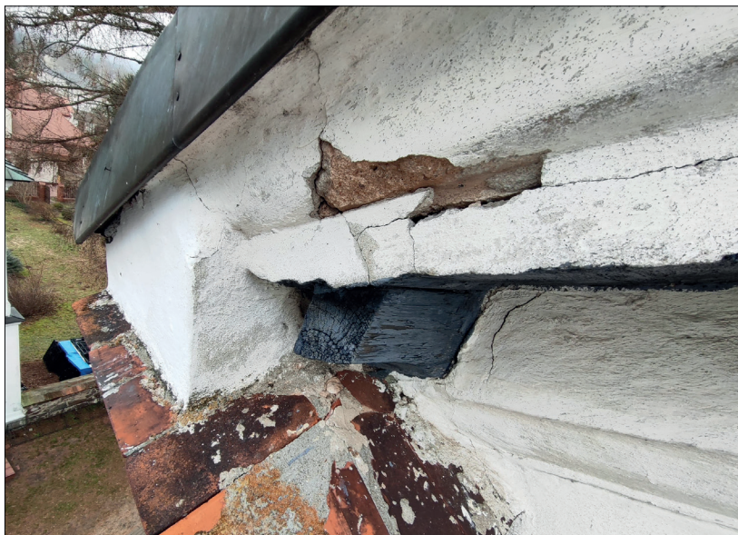
Fot. 26 Elewacja północna, widoczne spękania gzymsu w narożniku tympanonu.
