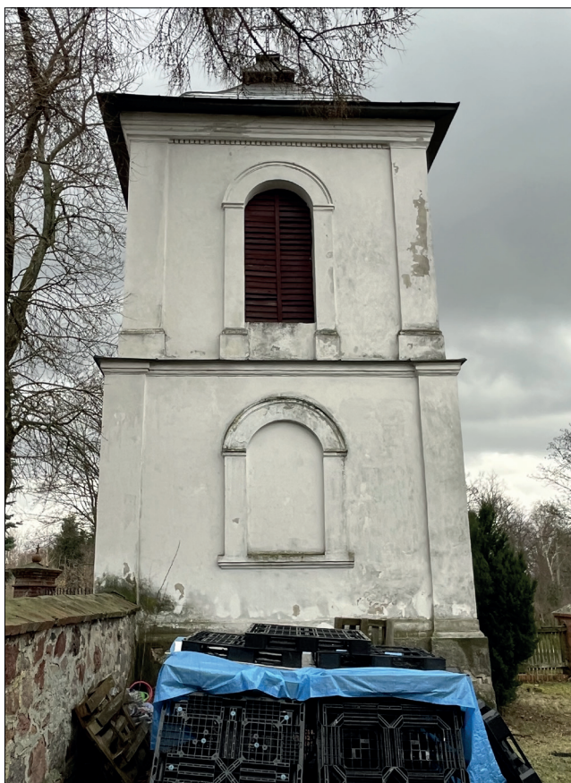
Fot. 33 Dzwonnica, elewacja północna, widoczne uszkodzenia warstw malarskich na skutek erozji.
