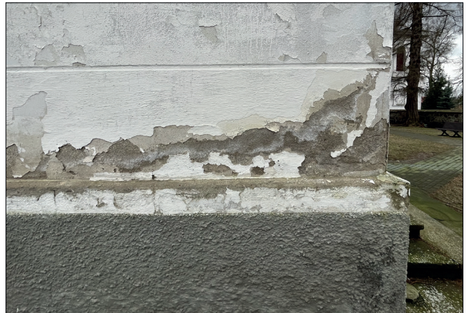
Fot. 4 Elewacja północna; widoczna znaczna dezintegracja struktury tynków przez wodę podciąganą kapilarnie i wysolenia.
