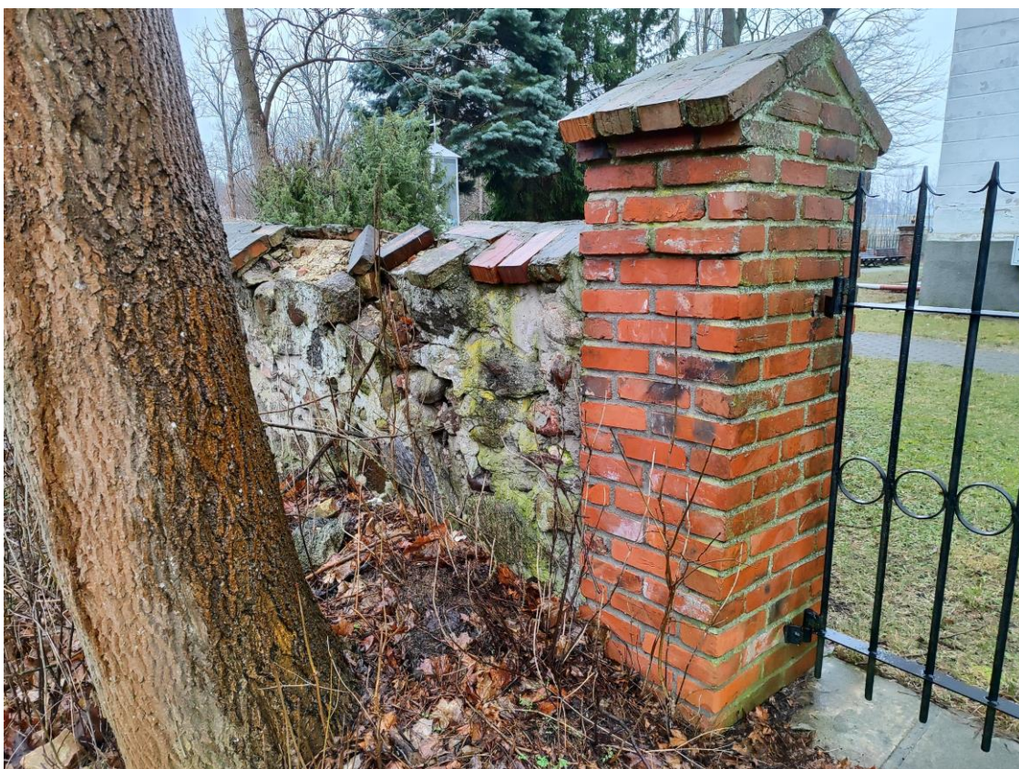
Fragment F-G – zniszczenie muru, spękania konstrukcyjne, osunięte fragmenty muru, ceglany słup ze szczelną spoiną, wysolenia.
