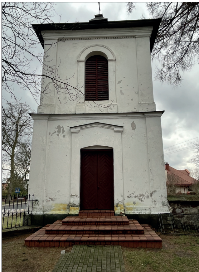
Fot. 31 Dzwonnica, elewacja wschodnia, widoczne zniszczenia w partii tynku narażonej na działanie wody.
